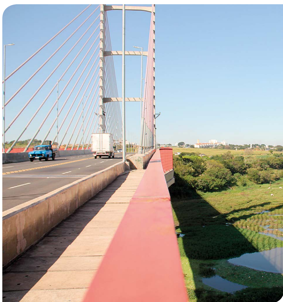
Ponte da Esperança tem 700 metros de extensão e 75 metros de altura
