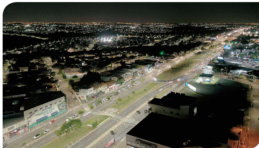
Luzes de LED são mais eficientes e reduzem o consumo de energia elétrica
