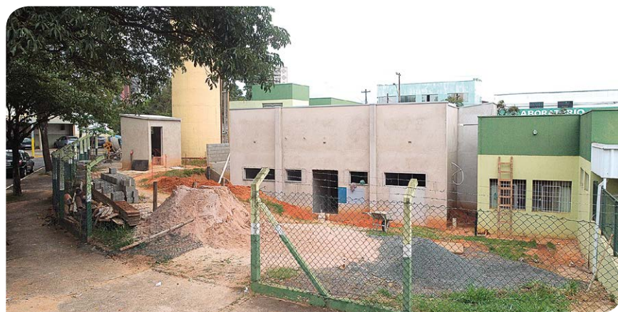
Obras da UTI do Hospital Municipal estão em ritmo acelerado
