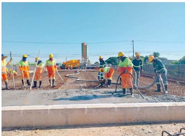
Obras dos viadutos sobre a SP-101 e no Jardim Nova Europa estão em fase final e vão melhorar a mobilidade urbana da cidade
